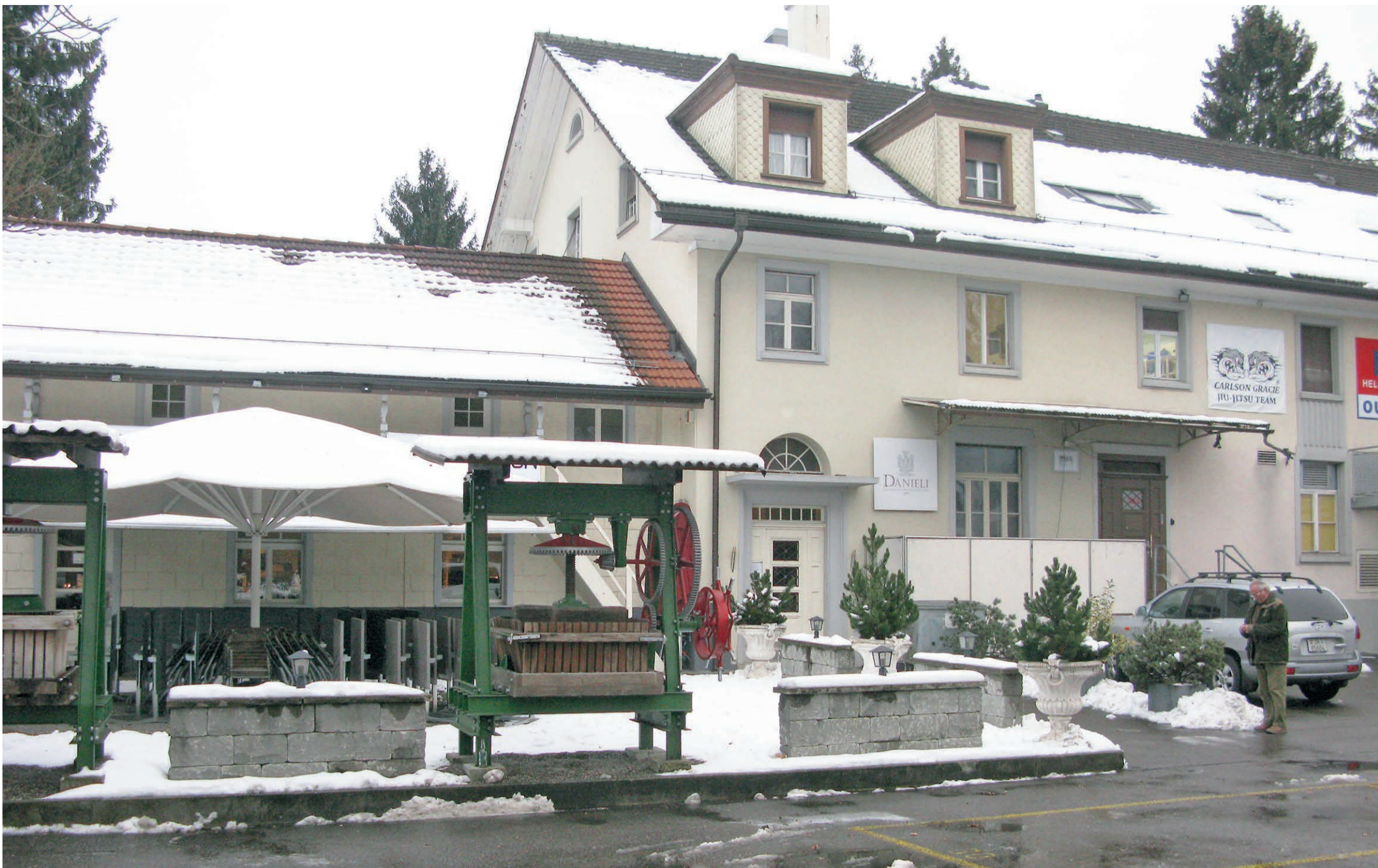
Am Grindelwald bei den Danielis werden bald die Baumaschinen auffahren. 72 Wohnungen werden erstellt, die Ende 2018 bezogen werden können.
